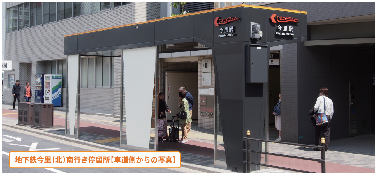
地下鉄今里(北)南行き停留所[歩道側からの写真]
